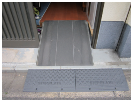
【玄関前の段差にスロープを設置】
