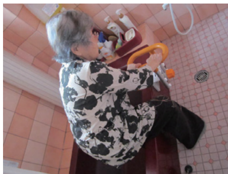
【浴槽に入る手すりを設置】
